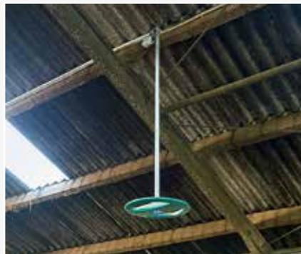
Das Tierortungssystem CowScout basiert auf Antennen, die im Abstand von 15 m über den Stall verteilt installiert sind.
