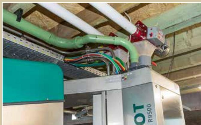
Für eine beschleunigte, einfachere Fehlersuche kommen nun bei den Leitungen für Wasser, Dippmittel und Druckluft unterschiedliche Farben zum Einsatz.
